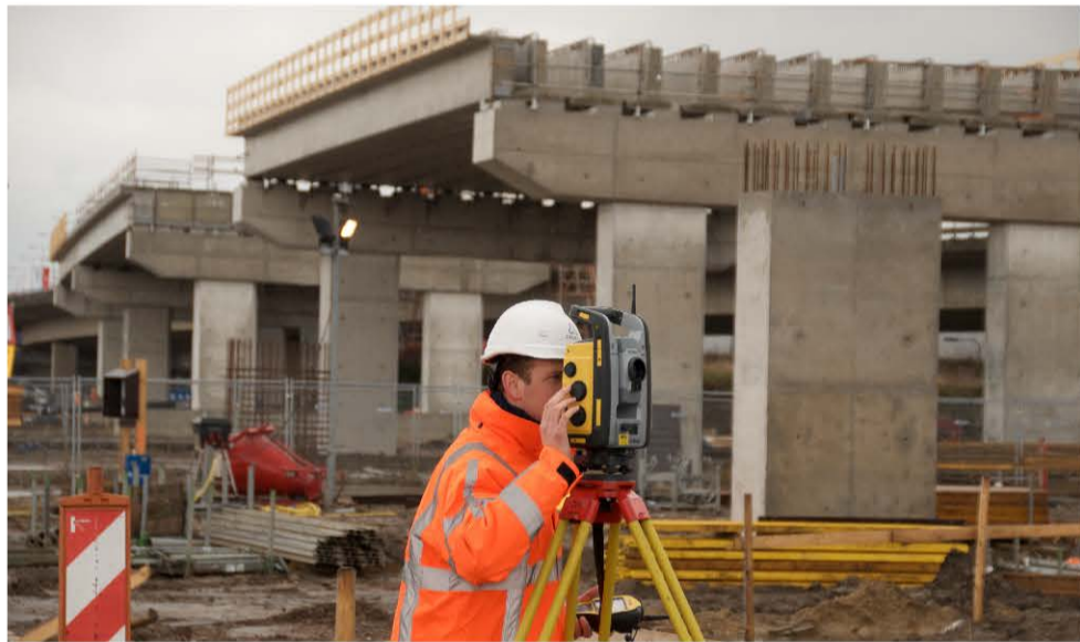
Maatvoering bij de Noorderbrug in Maastricht
