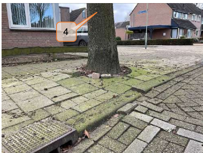
Foto 9 en 10: Beeld van wortelopdruk ter hoogte van de moseik met boomnummer 4 (links) en 7 en 8 (rechts) aan de Prins Hendrikstraat.
