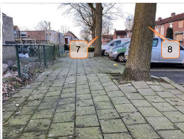
Foto 9 en 10: Beeld van wortelopdruk ter hoogte van de moseik met boomnummer 4 (links) en 7 en 8 (rechts) aan de Prins Hendrikstraat.
