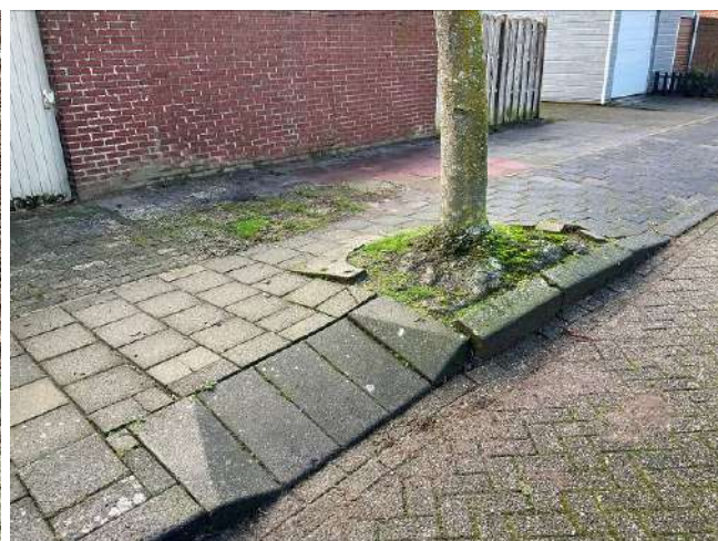
Foto 11 en 12: Beeld van wortelopdruk waarbij een wortel door de naad van de trottoirbanden komt ter hoogte van de pluimiep met boomnummer 20 (links) en boomspiegel van de bonte gewone esdoorn met boomnummer 33 die helemaal is opgevuld met houtweefsel en ernstige opdruk geeft aan de verharding. Beide bomen staan aan de Leeuwerikstraat.
