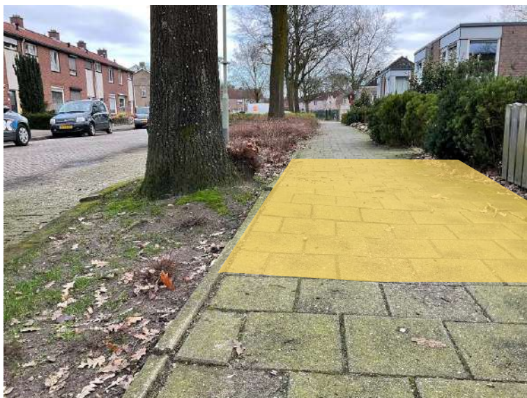
Foto 13: Impressie aan te brengen halfverharding ter hoogte van de moseik met boomnummer 5, aangegeven met oranje markering.
